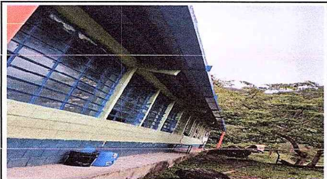
Se observa la sustitución de las ventanas y vidrios de la escuela.
