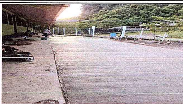
Se observa la colocación del nuevo piso.
