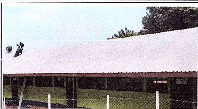
Se observa el cambio de los capotes del corredor del establecimiento.
