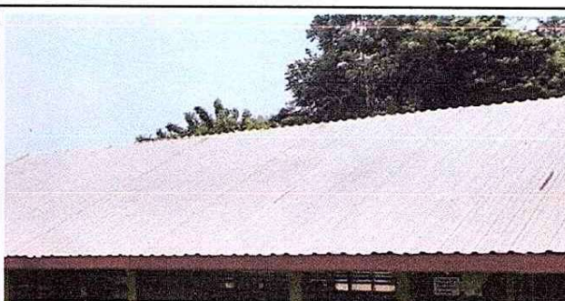
Se observa el nuevo techo de las laminas de la cocina.
